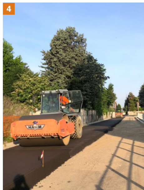
4 Cantiere di posa conglomerato bituminoso a freddo
