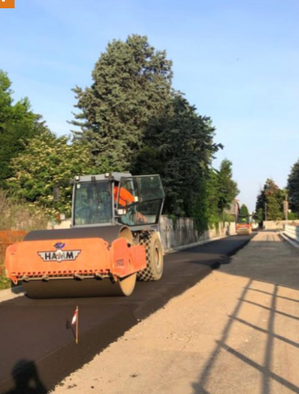
4 Cantiere di posa conglomerato bituminoso a freddo
