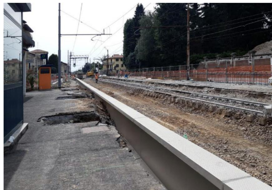
Binario rimosso per realizzazione di sottopasso pedonale in opera
