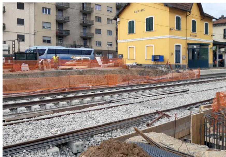
Binario riposato dopo realizzazione di porzione di sottopasso pedonale in opera
