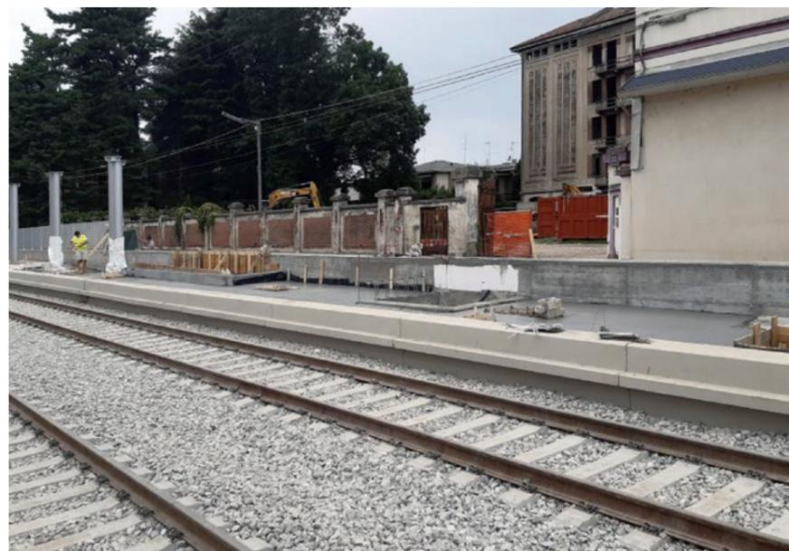
Binari riposati dopo realizzazione completa di sottopasso pedonale in opera
