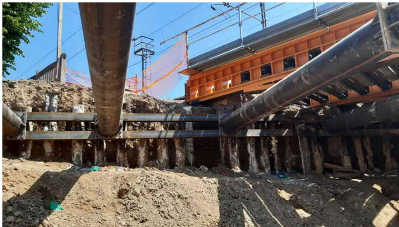
8) Il ponteGui.do dopo la posa delle travi di controspinta dei micropali
