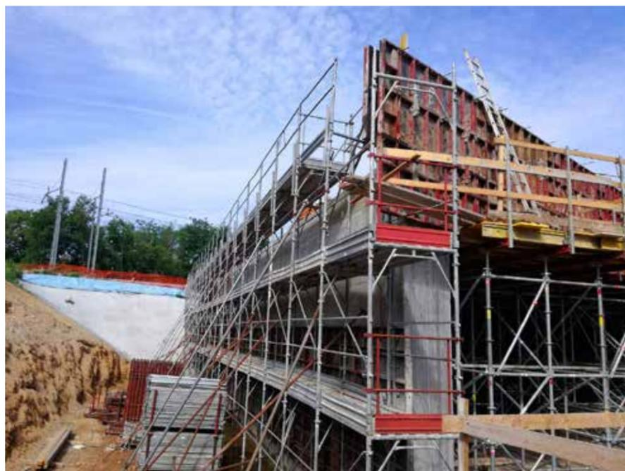
1) Costruzione del monolite in adiacenza al rilevato ferroviario per la successiva infissione mediante spinta con martinetti idraulici
