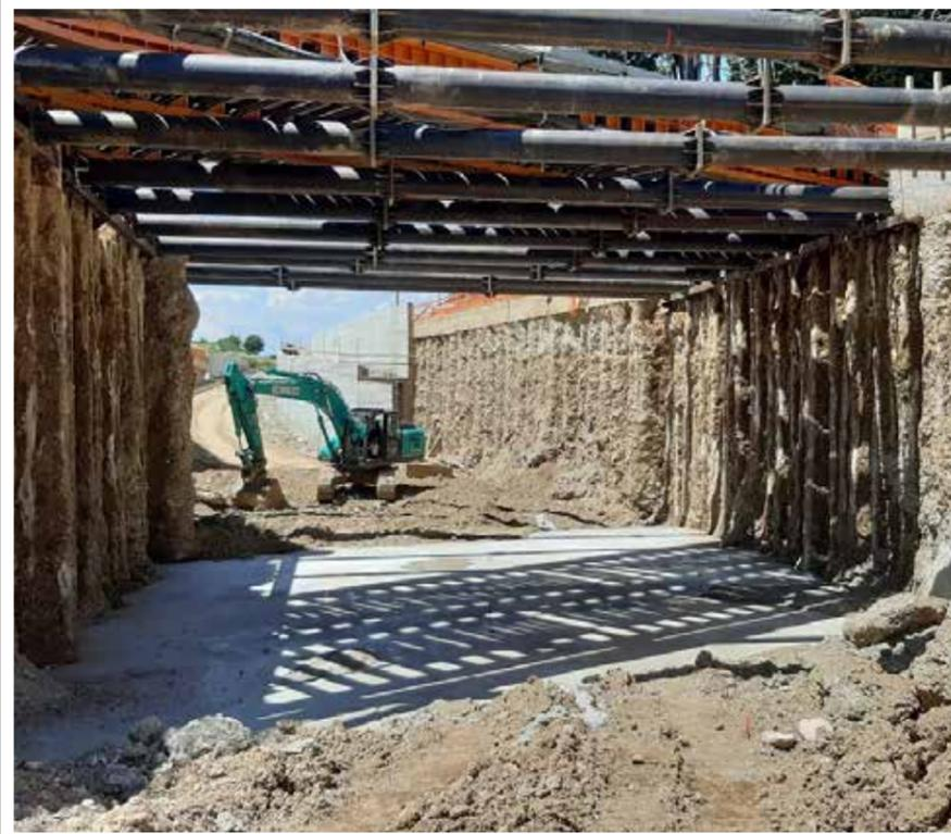
9) Il ponteGui.do con lo scavo sottostante pronto per la realizzazione del sottopasso
