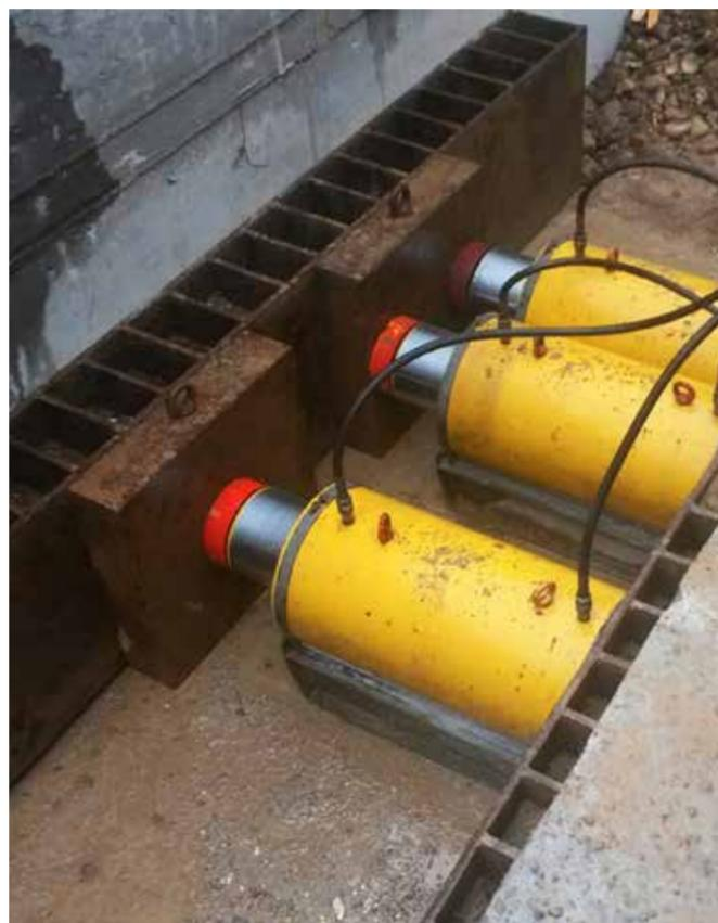
6) Martinetti idraulici di spinta del monolite
