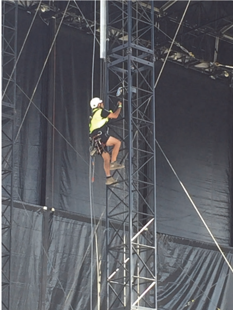
Figura 1.10 – 1 Verifica mediante salita con doppio cordino
