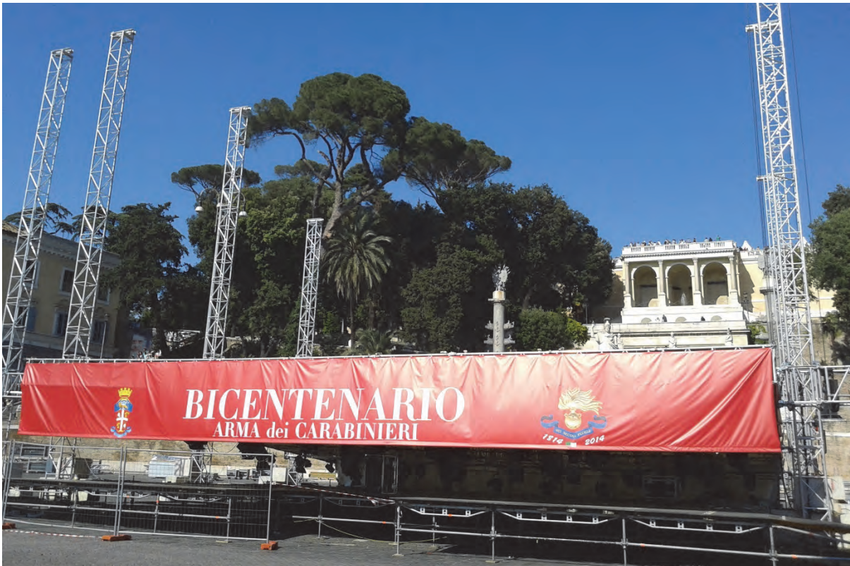
Figura 1.3 – 2 Esempio di palco (pedana, strutture verticali e struttura di copertura) realizzato con sistemi integrati con copertura assemblata a terra
