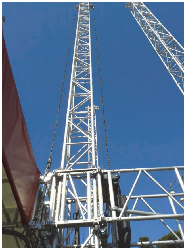
Figura 1.3 – 3 Esempio di sistema di sollevamento della copertura
