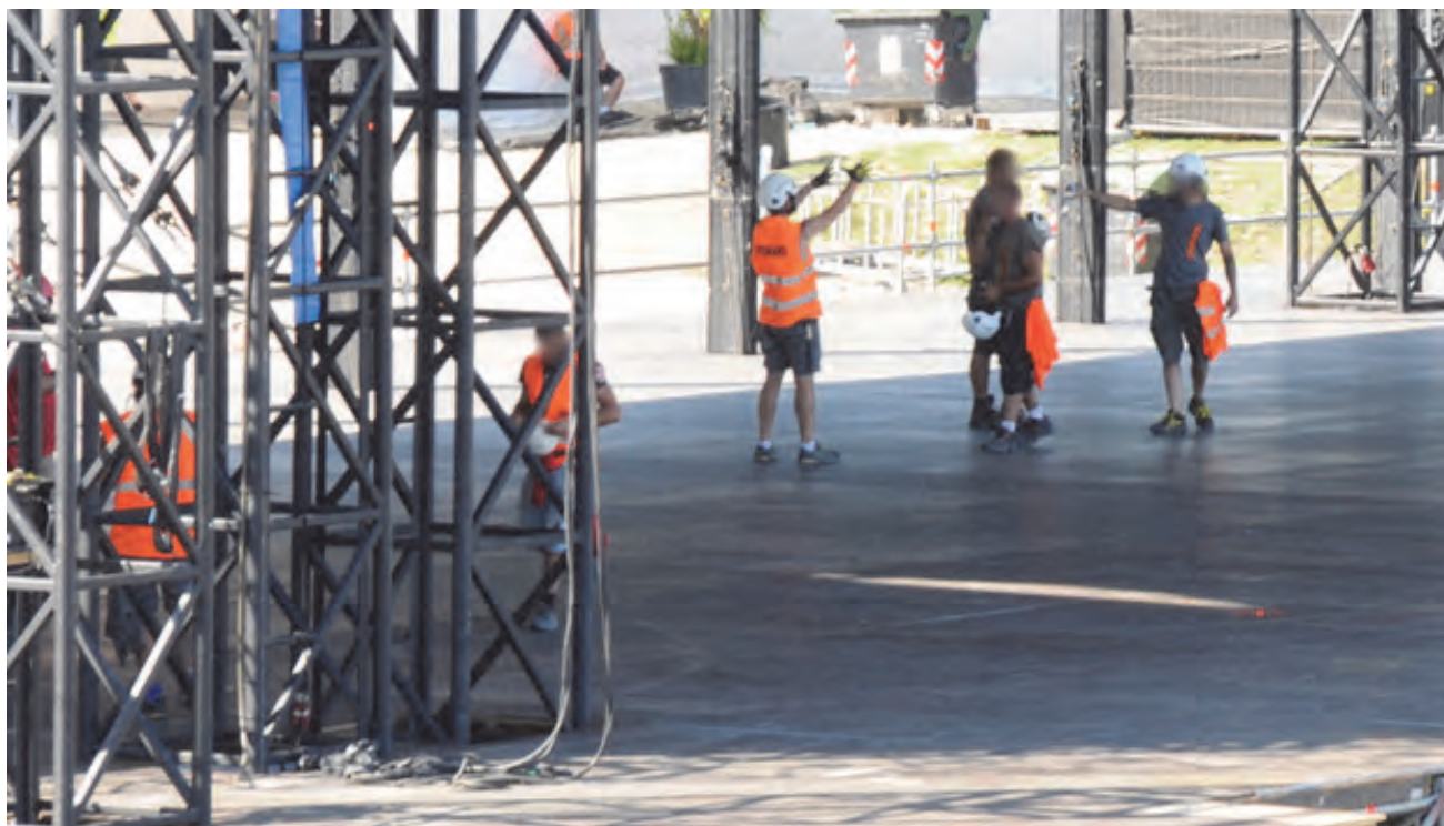
Figura 1.7 – 3 Fasi di montaggio, smontaggio ed allestimento – Necessità del coordinamento
