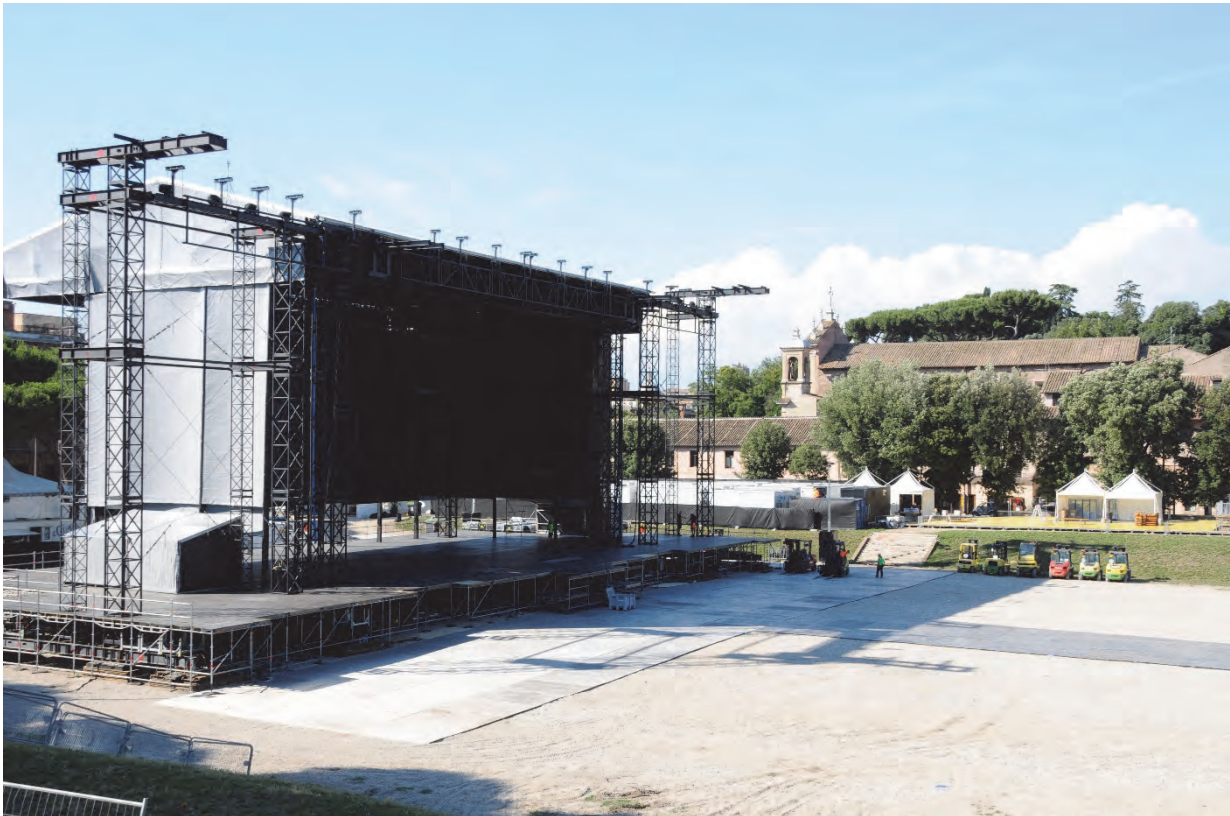
Figura 1.3 – 1 Esempio di palco realizzato con sistemi integrati
