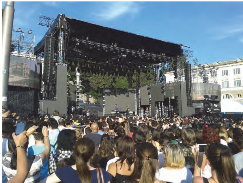
Figura 1.4 – 6 Esempio di palco realizzato con sistemi integrati
