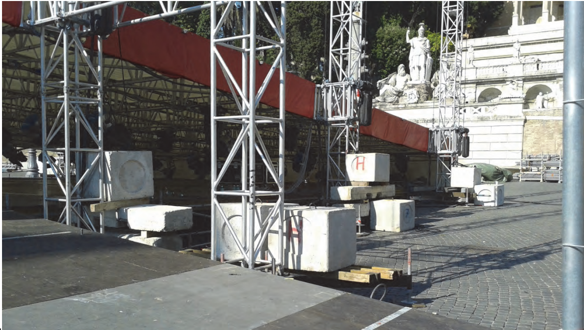
Figura 1.3 – 4 Esempio di posizionamento della zavorra
