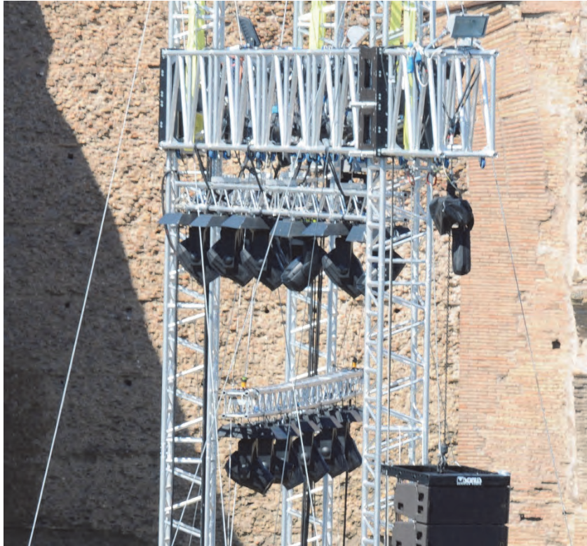
Figura 1.3 – 9 Impianto luci, particolare
