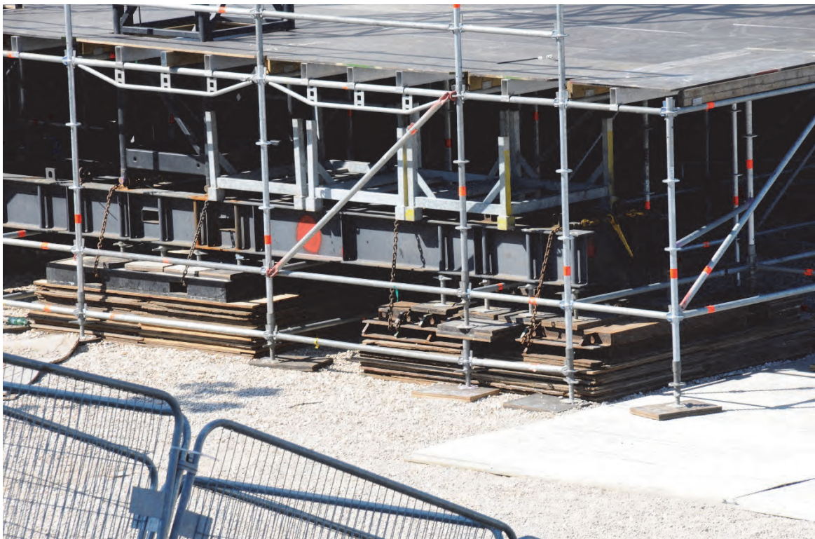
Figura 1.3 – 5 Esempio di livellamento
