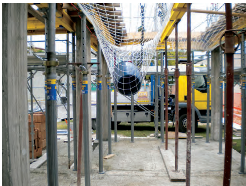
Figura 27 – Foto della prova in situ della rete con un peso di 100 kg lasciato cadere ad un'altezza superiore a 100 centimetri dal piano d'imposta della rete
