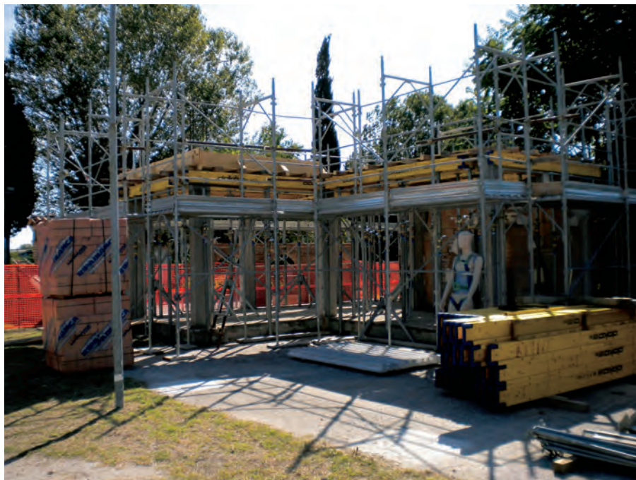
Figura 5 - Foto del cantiere di sperimentazione
