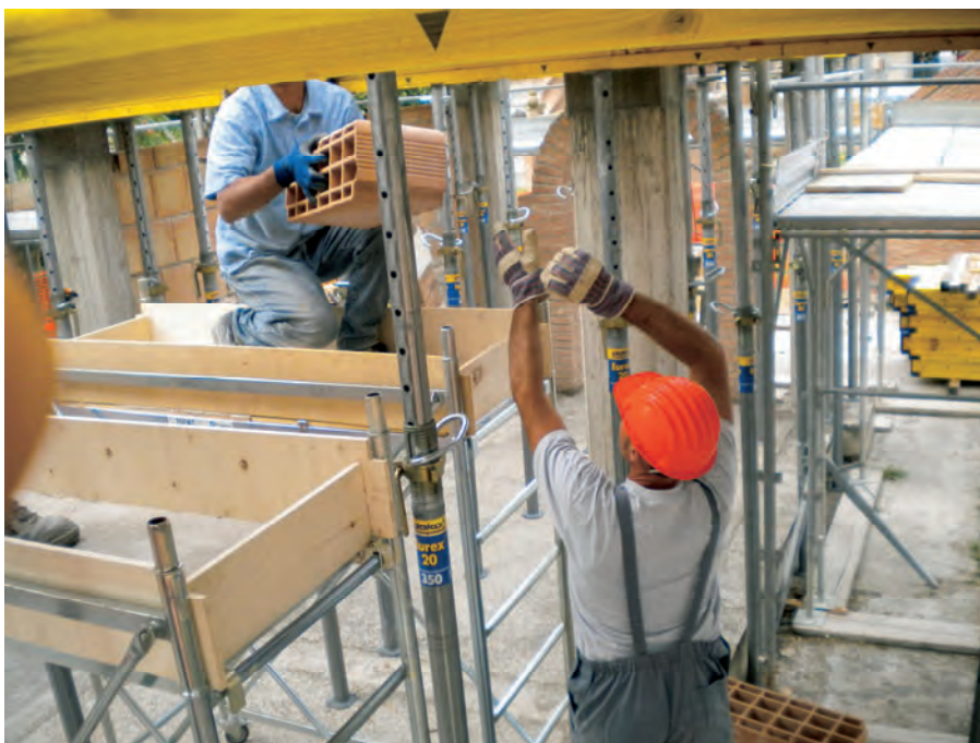
Figura 19 – Fase del passaggio delle pignatte dal basso
