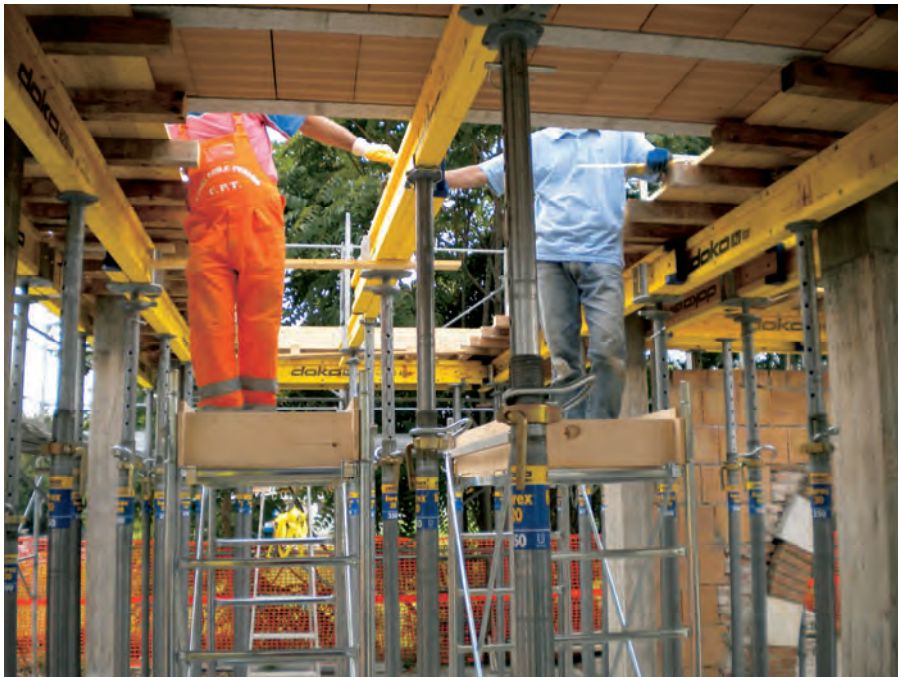
Figura 16 – Uso di ponti su ruote di ridotte dimensioni per la posa di travetti e pignatte dal basso
