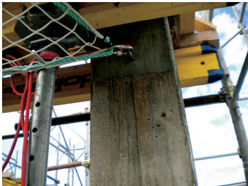
Figura 25 – Dettaglio dell'ancoraggio d'angolo della rete al pilastro
