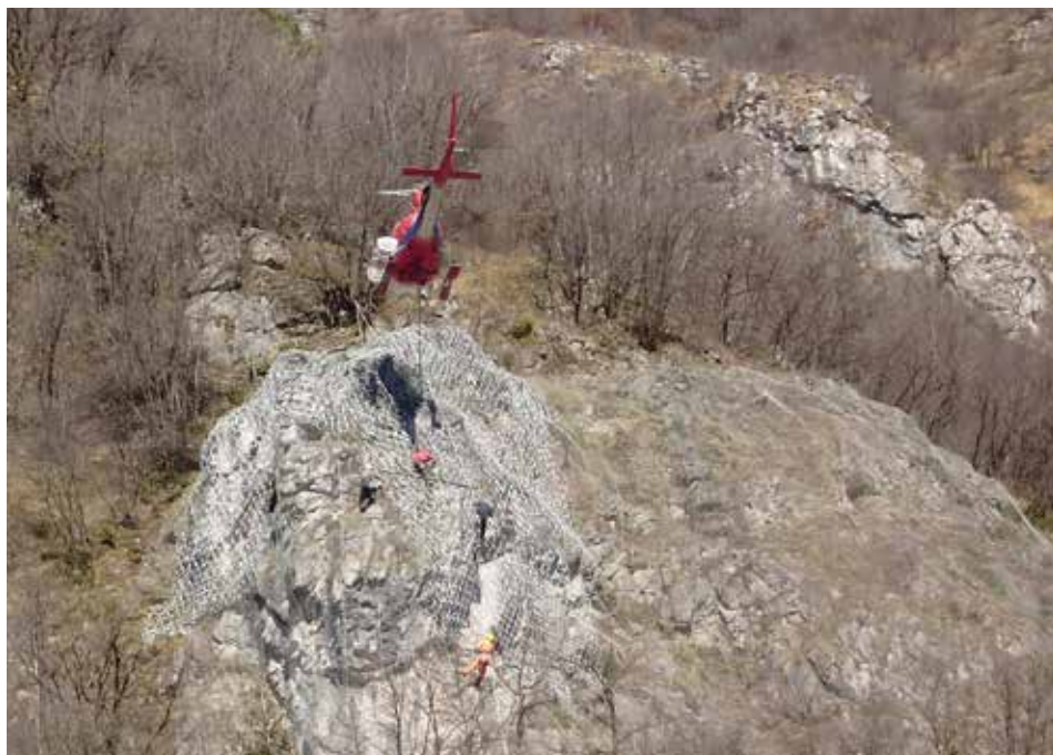
Una delle fasi di posa delle reti
